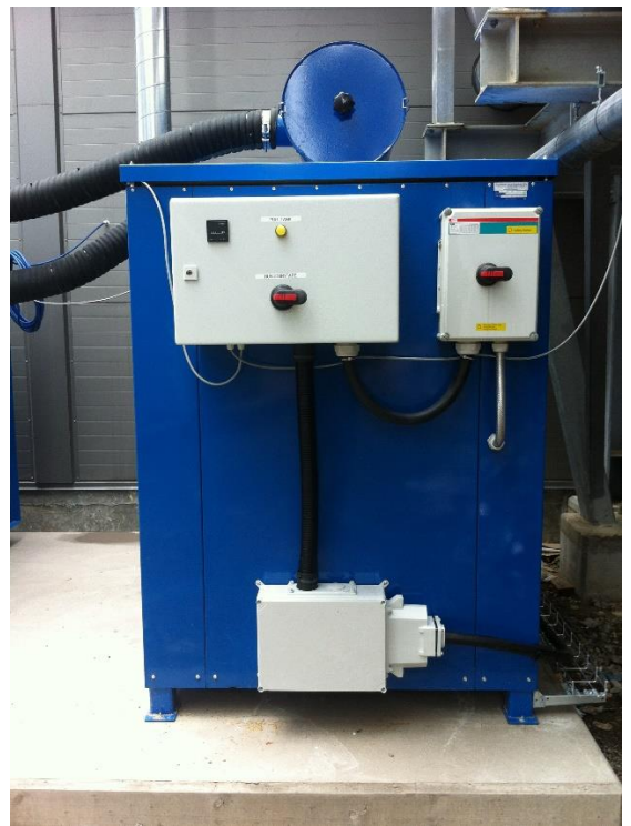
Bilden visar 37kW rootspump i eget bullerhus med utvändigt säkerhetsfilter
