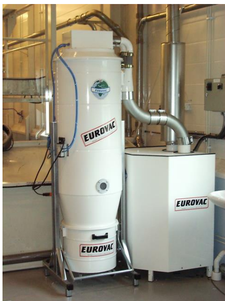
Bilden visar 11kW sidokanalfläkt i eget buller
