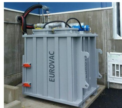
Bilden visar en 2m 3 filtercontainer
