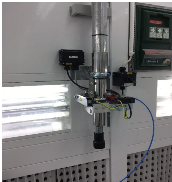
Bilden visar exempel på 50mm automatspjäll kopplad till rörsystem
