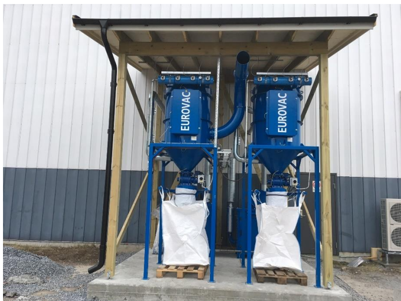
Bilden visar 2st filterenheter 900 med utmatning i storsäck
